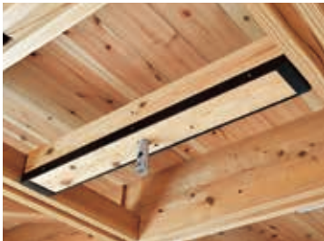
S-03 好きな場所に柱を立てたり、吊るためのパーツ
