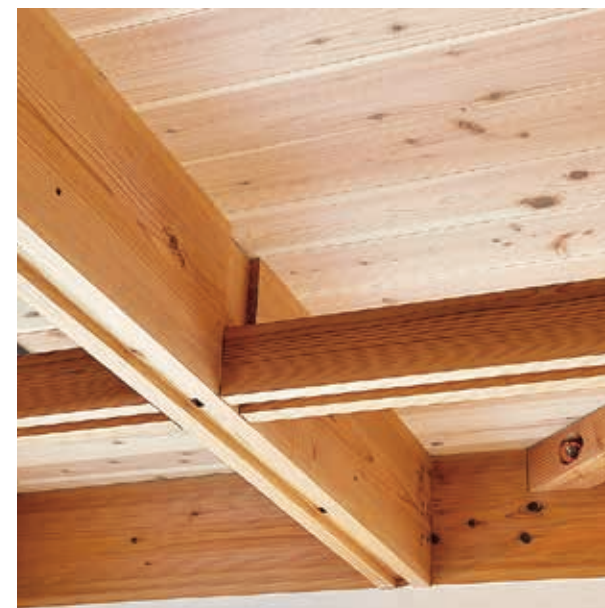
浮き梁 は見た目も機能性も抜群
